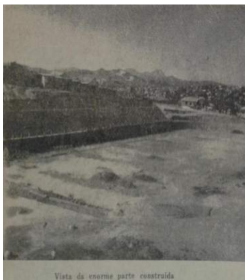
Vista da enorme parte construída
