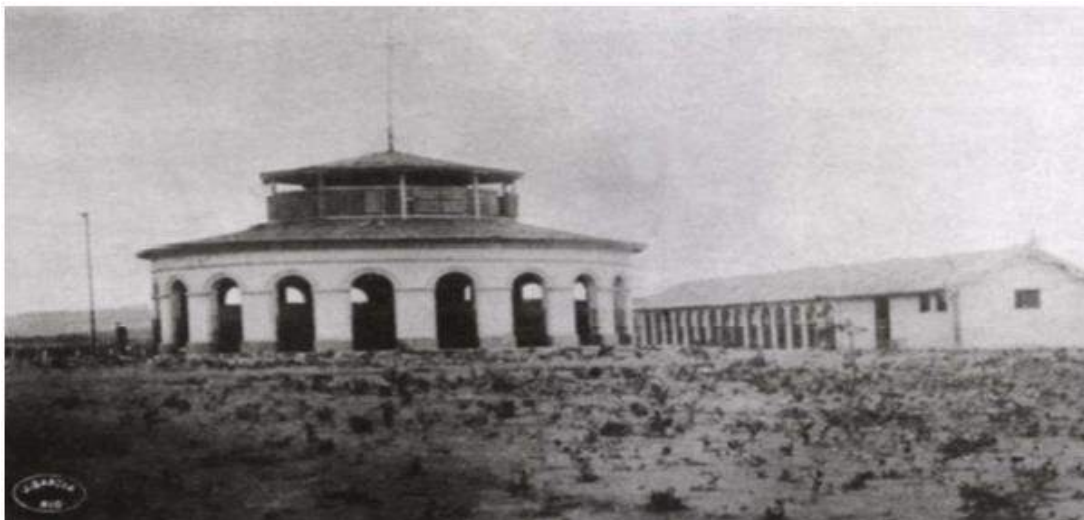
Figura 9 – As cocheiras do Prado Mineiro, em evidente estado de abandono.
