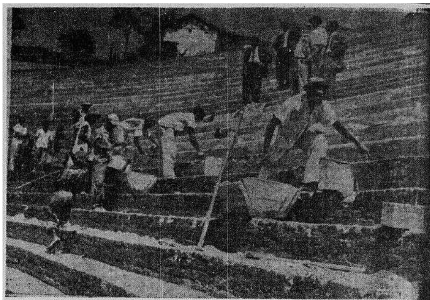
3 – Também foram iniciados os trabalhos de cimentação dos degraus, somando 30, em torno de todo o estádio. Toda a parte da imensa curva já está pronta, estando os operários em atividade nas duas retas. Também a outra curva, de concreto armado, será iniciada esta semana 178 , já que o projeto ficou pronto e o serviço de terra também teve início 179 .
