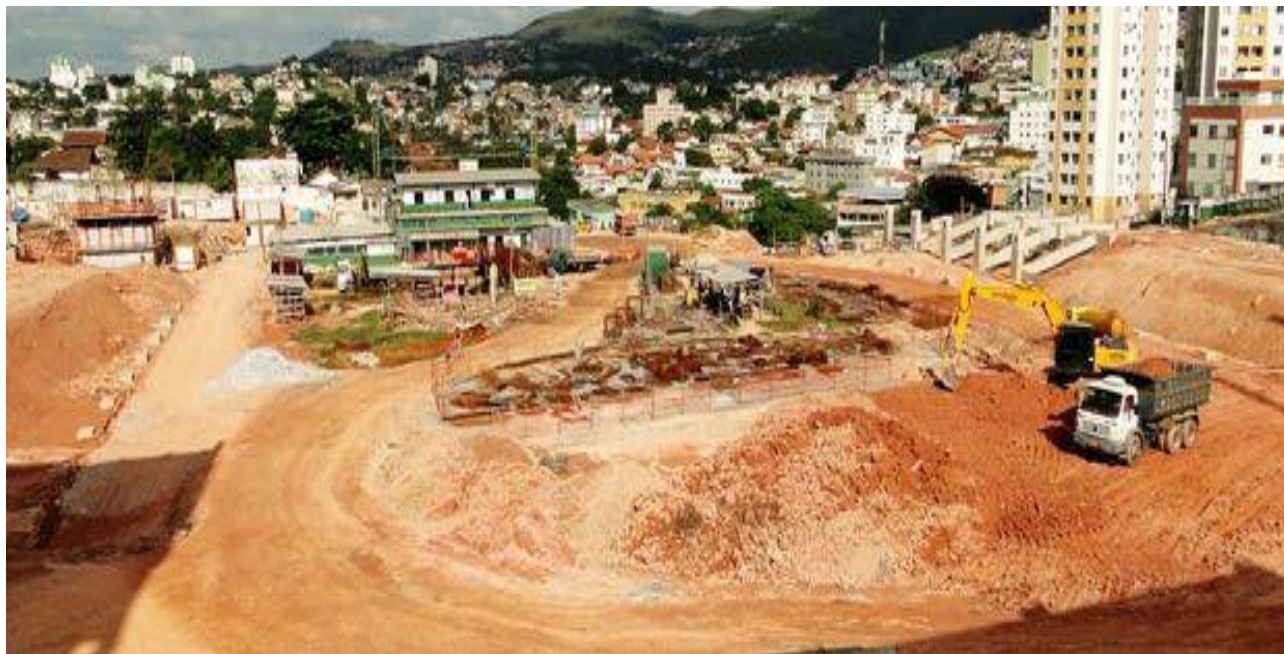
Figura 54 - Obras no Estádio Independência
