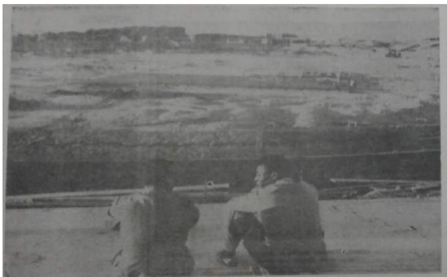
Figura 84 – Pelé e Zito visitam as obras do Estádio “Minas Gerais”.
