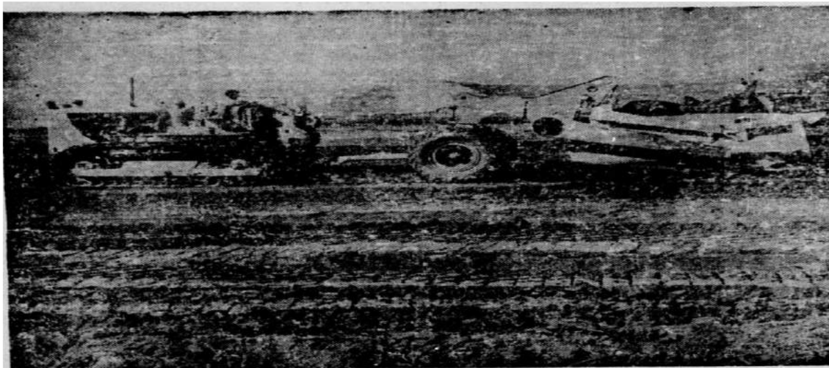
Figura 76 – Máquinas trabalhando no estádio.
