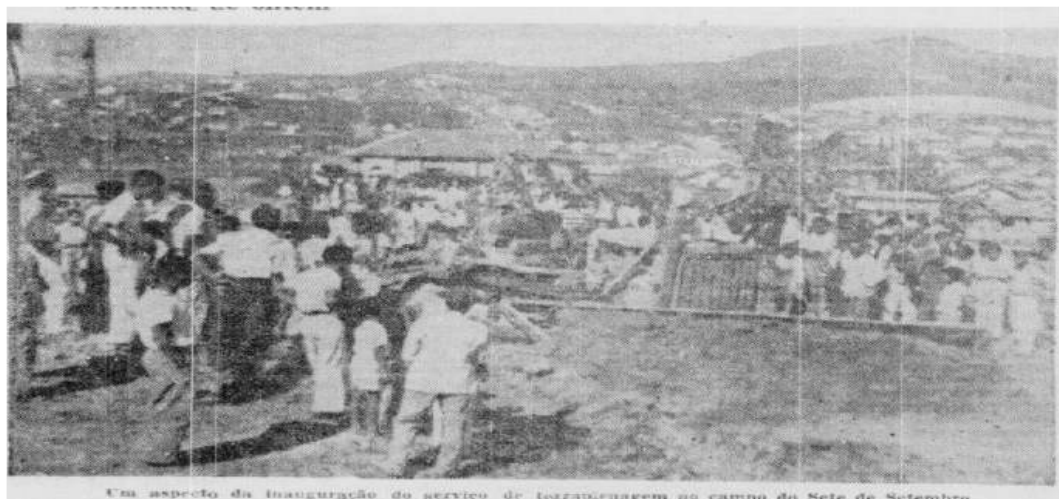
Figura 36 - Aspecto da inauguração do serviço de terraplanagem no campo do Sete de Setembro
