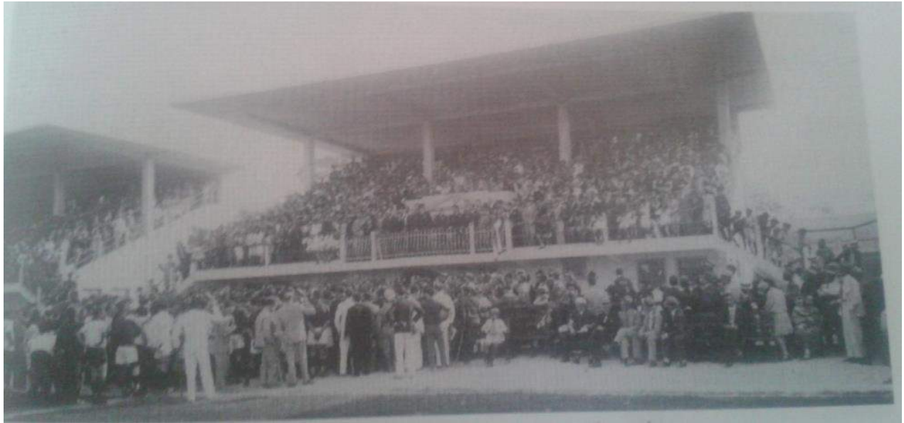
Figura 24 – Inauguração do estádio da Av. Araguaya
