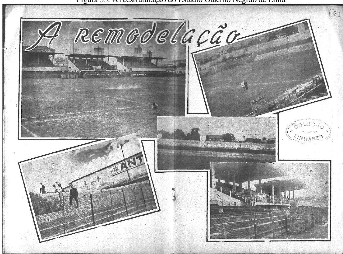
Figura 33: A reestruturação do Estádio Otacílio Negrão de Lima
